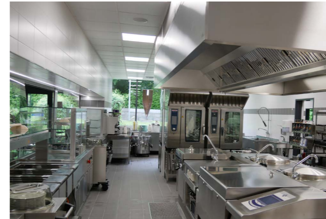
In der neu umgebauten Küche können Mensateam, Lehrkräfte und Schüler*innen gut zusammenarbeiten.
